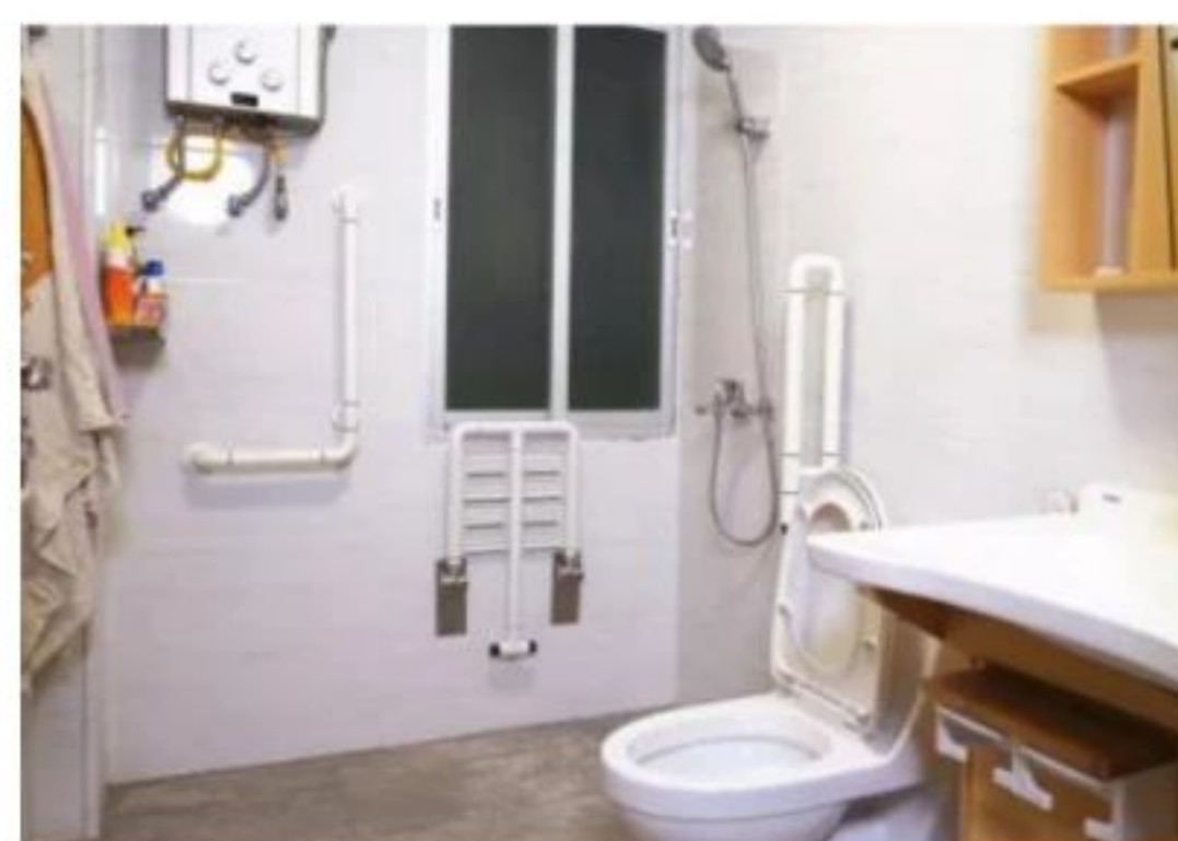
图 38 坐便器改造方法及效果示意
