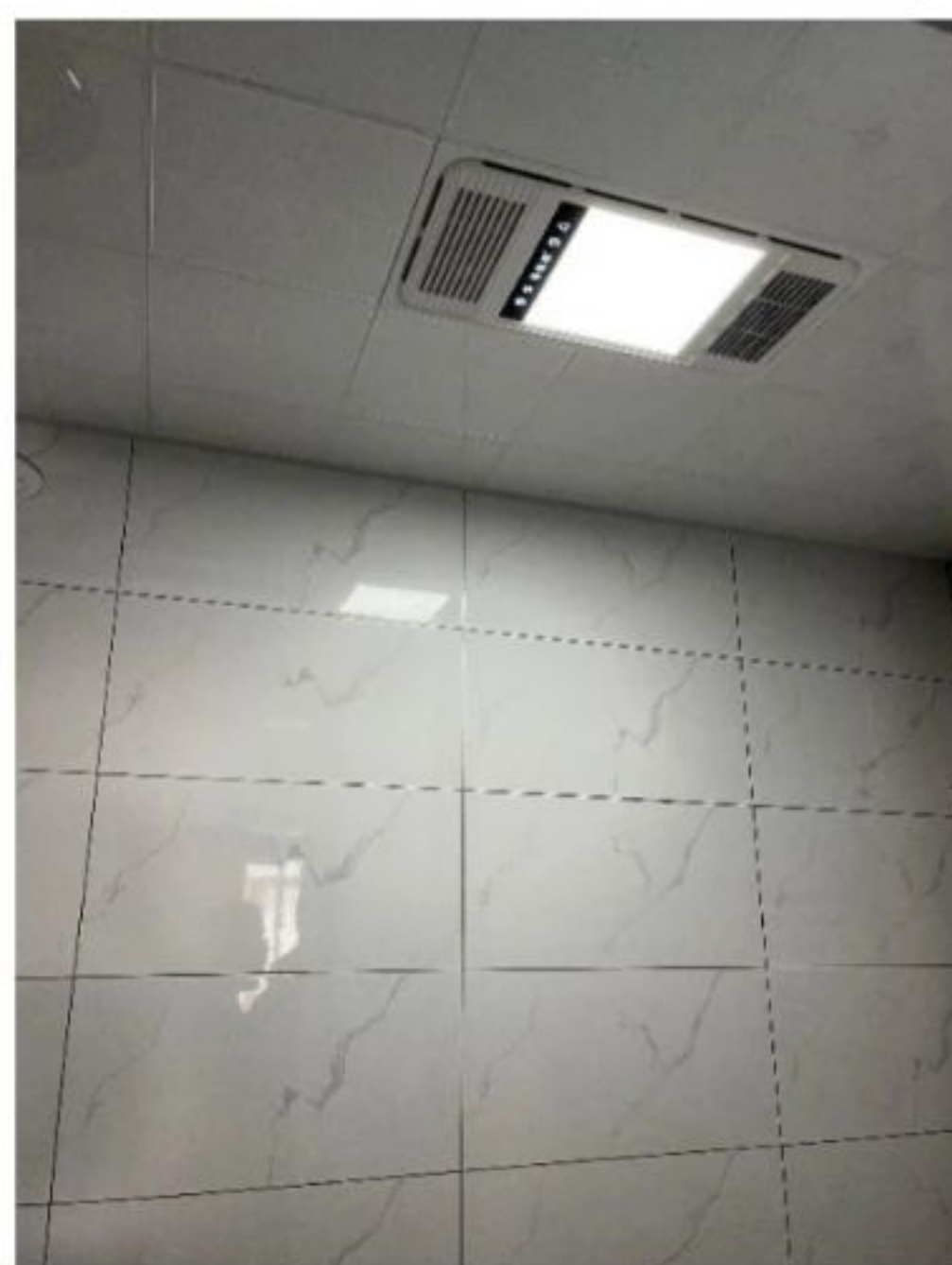
图 46 三合一暖风机安装做法及效果示意
