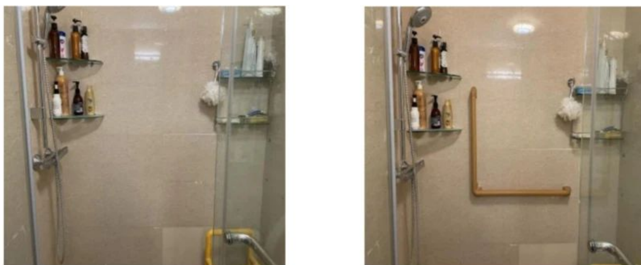
图 41 抓杆安装示意
